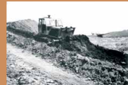
začátek rekultivací, zemní práce
